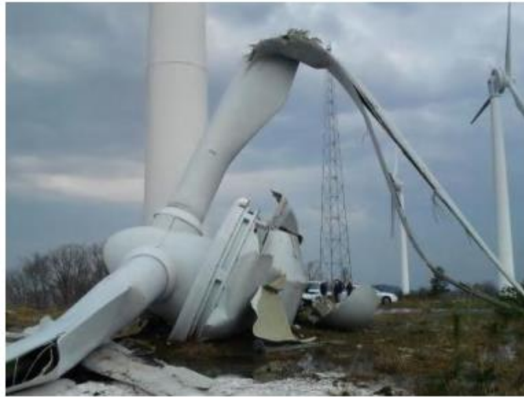
Figura 1.1: Aerogerador do parque eólico de Taikoyama caído [3].
