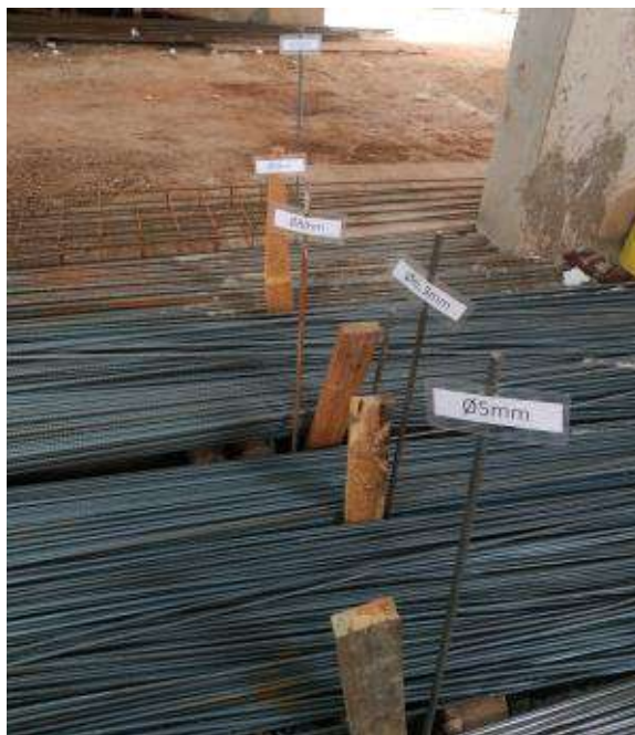
Figura 13: Aço separado e identificado. Gonçalves, 2019.
