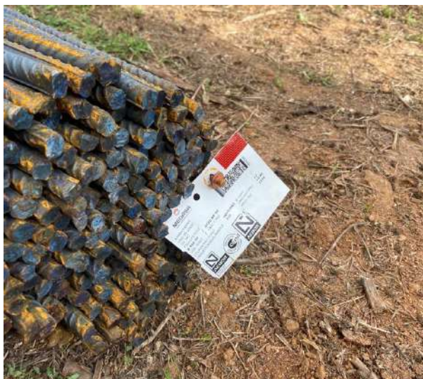
Figura 10: Identificação de atados de aço. Autoria própria, 2023.
