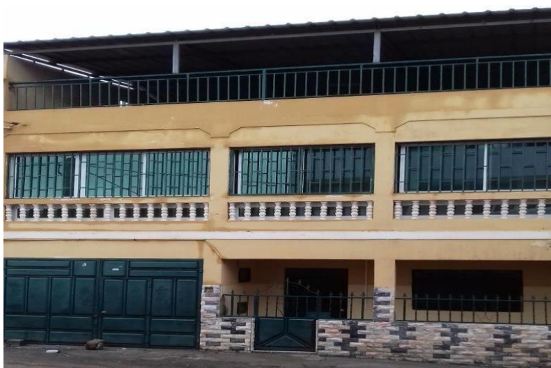
Figura 25 - Residência utilizada no caso de estudo. Fonte (Autoria do autor)
