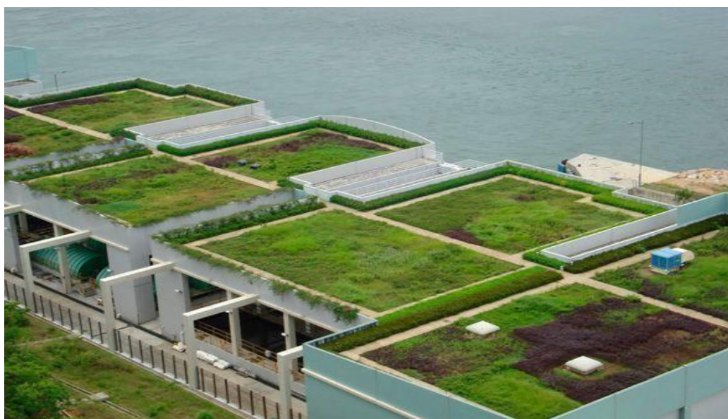
Figura 15 - Coberturas Verdes. Fonte [25]
