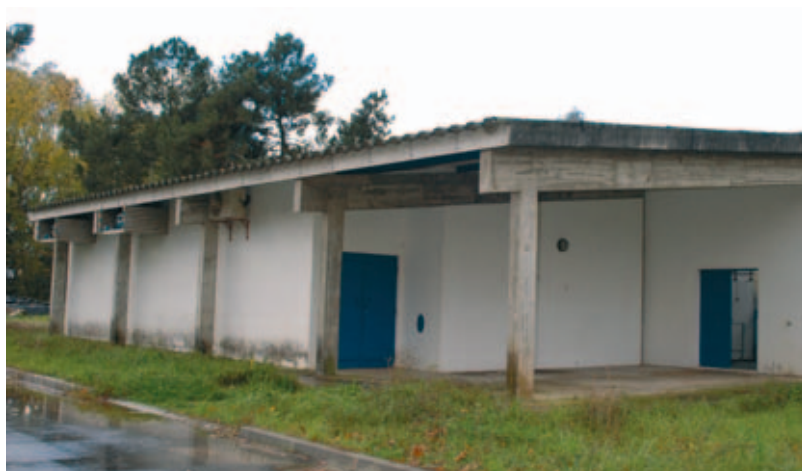
Figura 1. Instalações com controlo de luz da Universidade de Trás-os-Montes e Alto Douro. Nestas instalações, para além do controlo automático do número diário de horas de luz, controla-se igualmente a temperatura do ar e o nível de ventilação.
