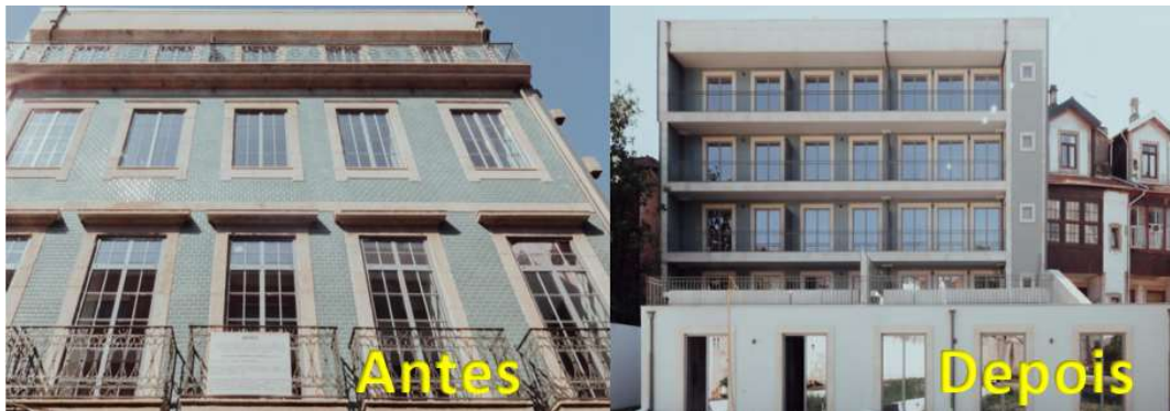
Figura 16 -Obra Edifício Rua da Torrinha, antes e depois
