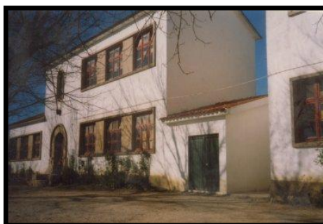
Fig. 1: Edifício do jardim de infância
