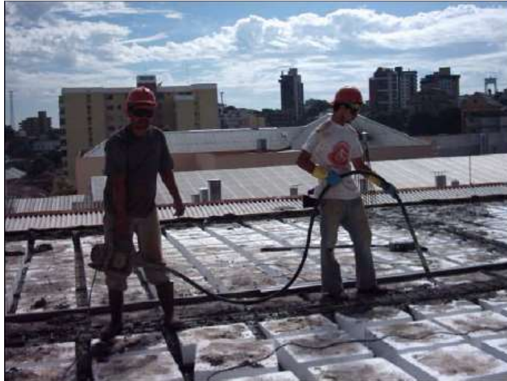
Figura 10 - Utilização do vibrador convencional Fonte: Juliana Kurek (2005)
