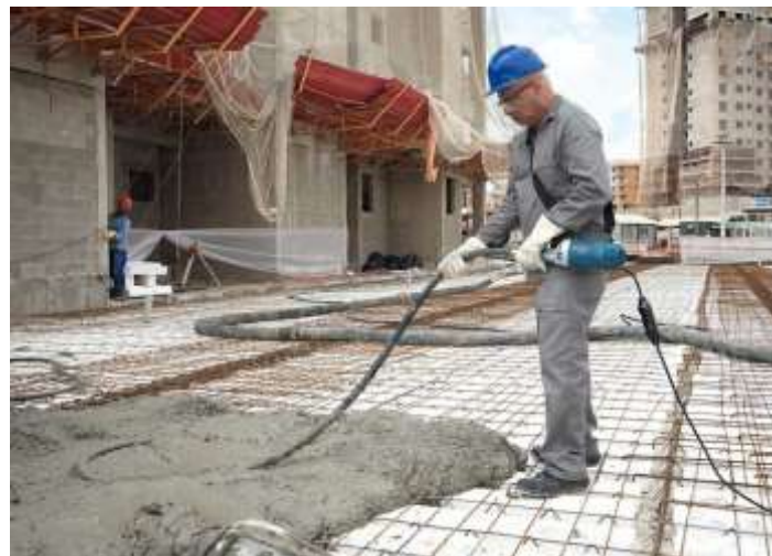
Figura 11 - Utilização do vibrador portátil Fonte: Construtora FG
