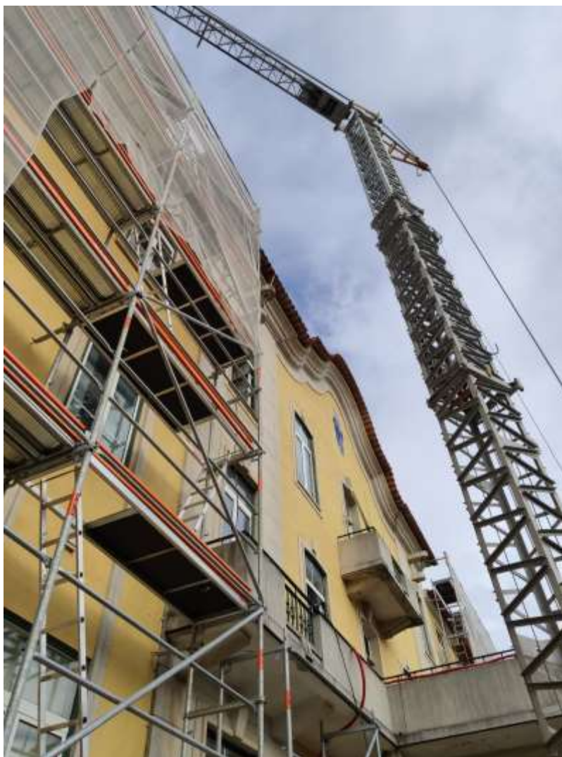
Figura 22 - Fachada externa do Seminário
