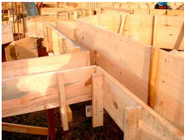
Figura 5 – Produção de formas em obra Fonte: Cia da obra
