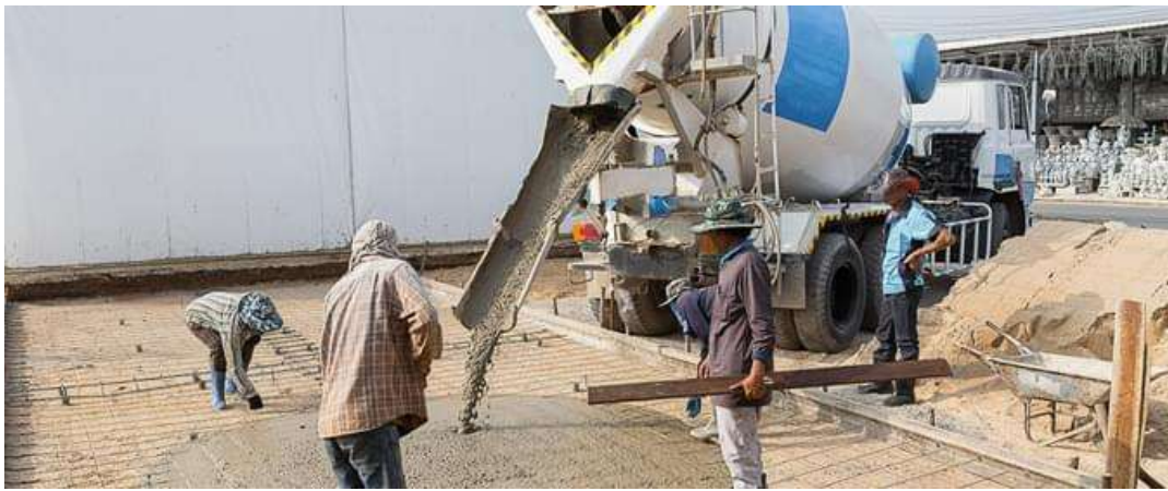
Figura 14 - Concreto industrializado chegando em obra Fonte: AEC Web
