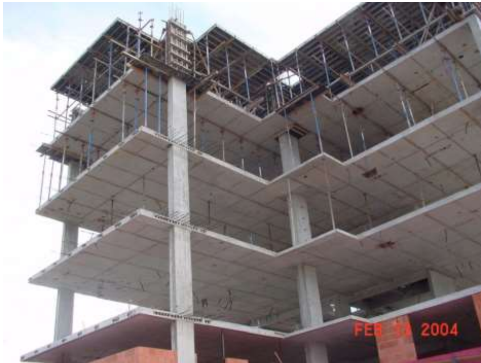
Figura 15 - Exemplo laje plana Fonte: Inova Civil
