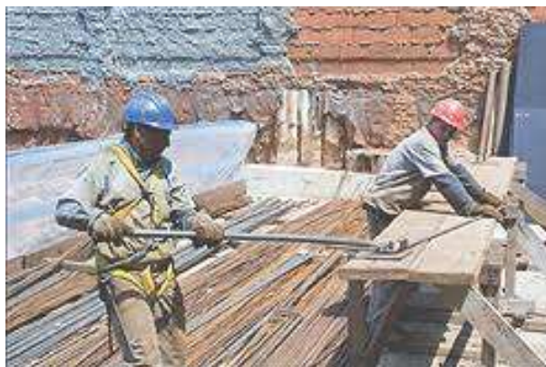
Figura 12 - Aço sendo cortado e dobrado em obra Fonte:Casa Serralheiro
