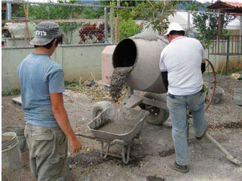
Figura 2 - Concreto sendo feito em obra Fonte: Engenharia Concreta
