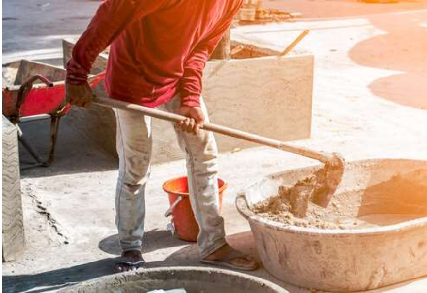
Figura 3 - Argamassa convencional sendo feita em obra
