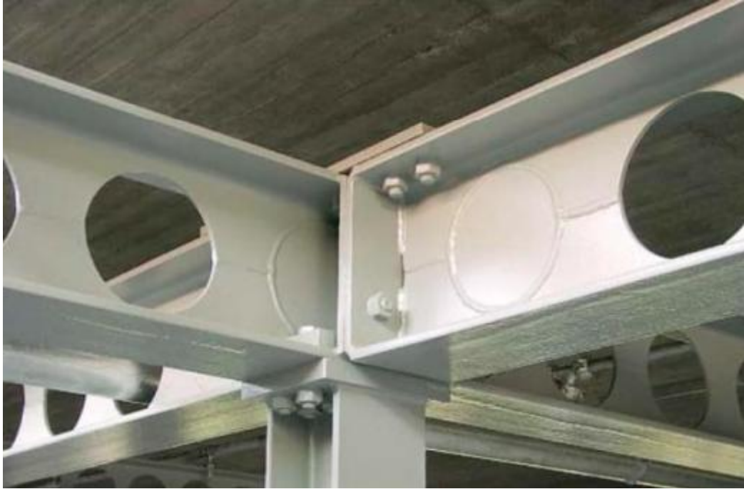
Figura 2.19: Preenchimento da Furação, [21].
