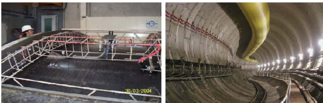
Figura 1.8 - Dovelas túnel Metro Barcelona Línea 9
