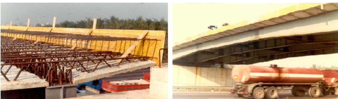
Figura 1.11 - CSTCB Puente Autopista A4
