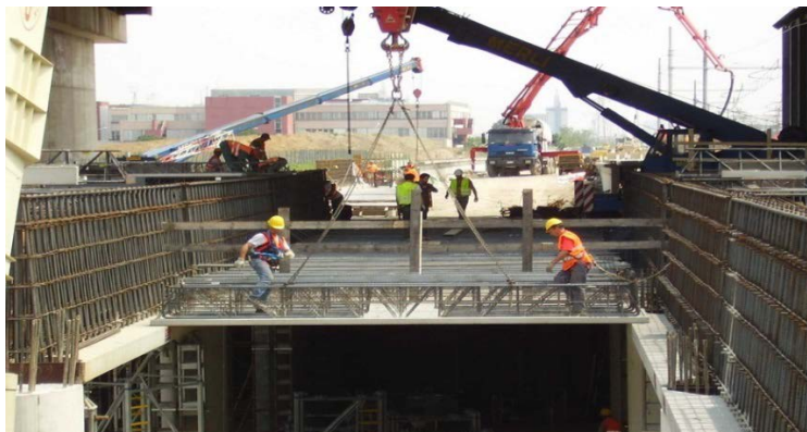
Figura 1.7 - Colocación en obra
