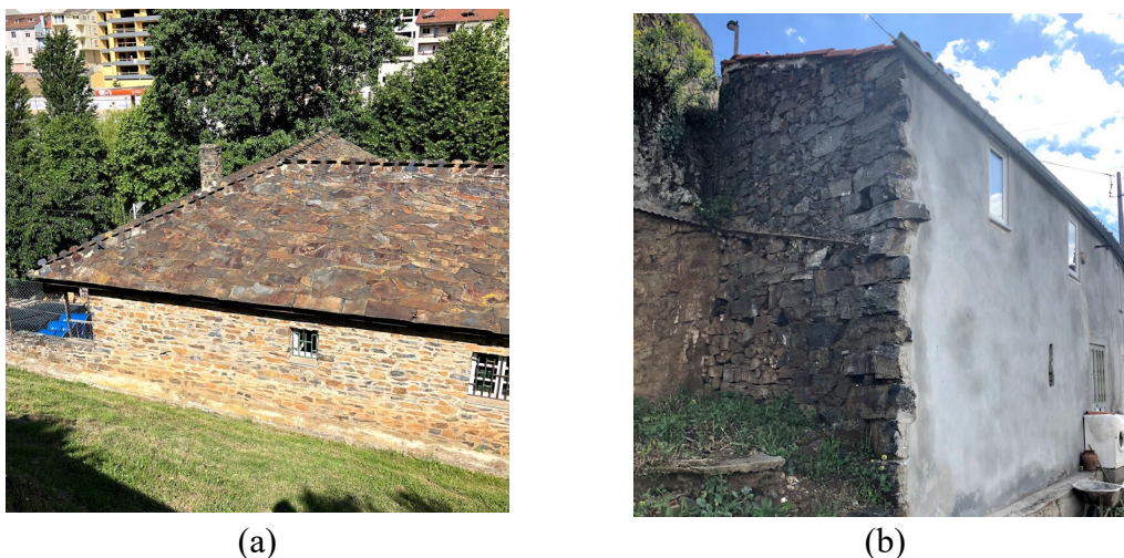
Figura 6 – Utilização de xisto em construções: (a) com função de telhado; (b) coberto por argamassa de Cimento Portland.
