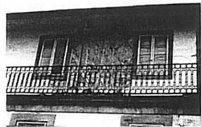
Figura 17: Processo tecnológico antigo numa parede de um edifício em Chaves.
