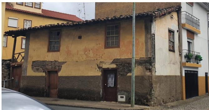
Figura 13 - Exemplo de construção em Tabique
