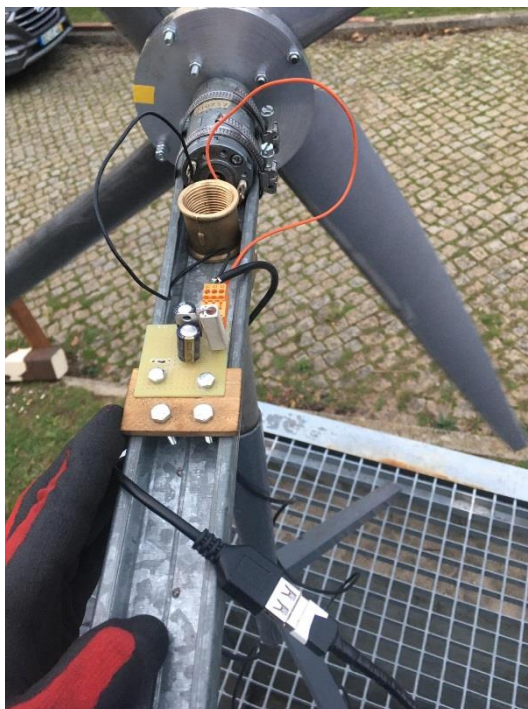
Figura 32 - Circuito eletrónico instalado
