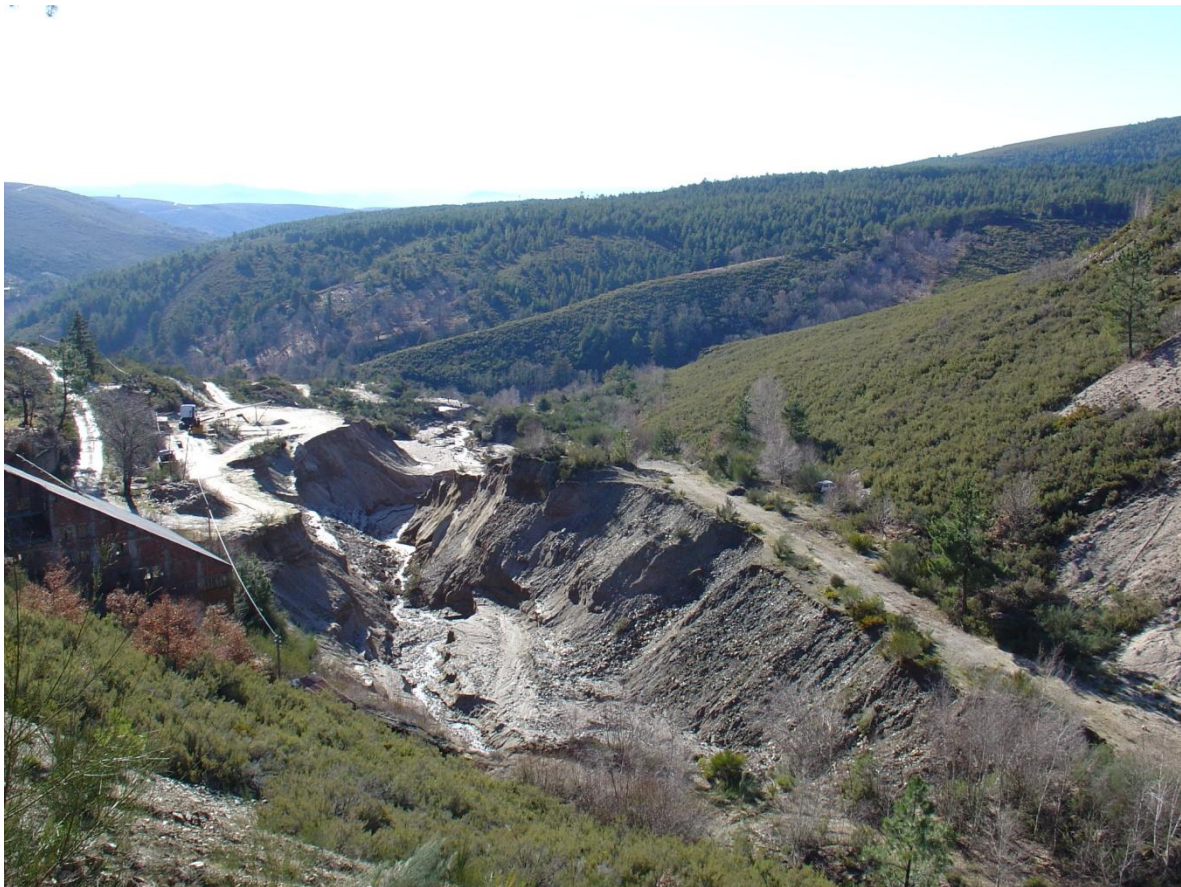
Figura 2. Zona do colapso das escombrelas da Mina do Portelo (abril 2012).
