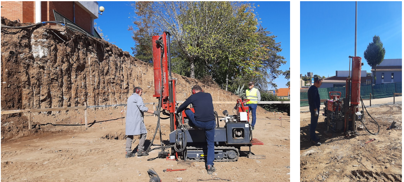
Figura 2 – Local de realização dos ensaios e equipamento de perfuração.
