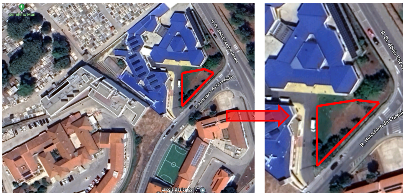
Figura 1 – Vista aérea do local da obra (imagens do Google Maps).
