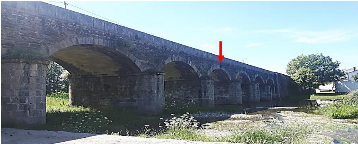
(a) Locação longitudinal
