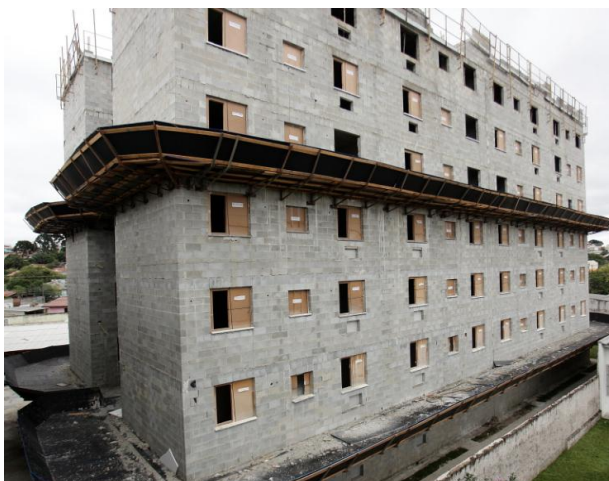
Figura 12: Construção brasileira do PMCMV com o emprego de blocos estruturais
