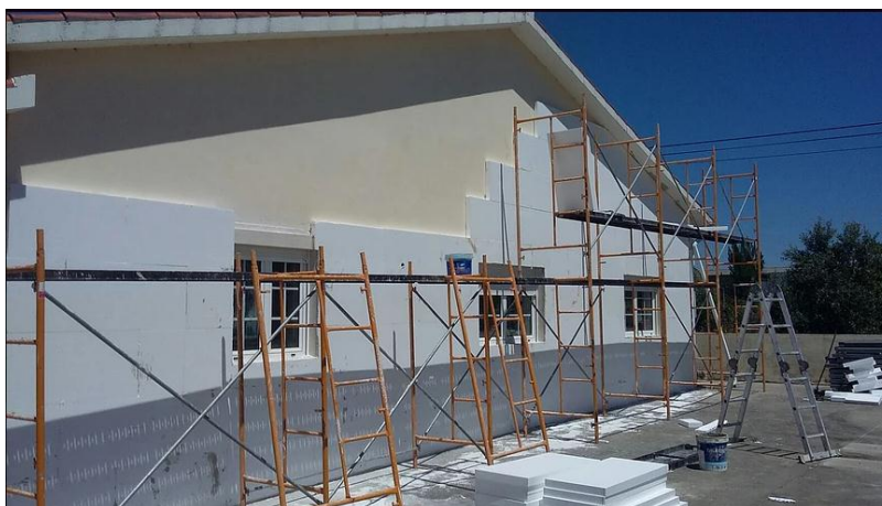
Figura 11: Construção portuguesa com o emprego de ETICS
