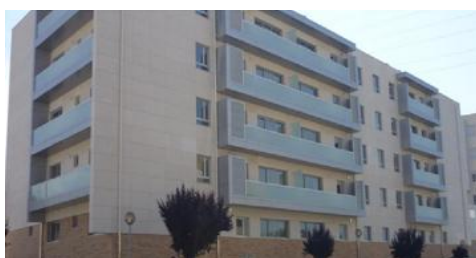
Figura 1: Obra de HCC em Gueifães [23]
