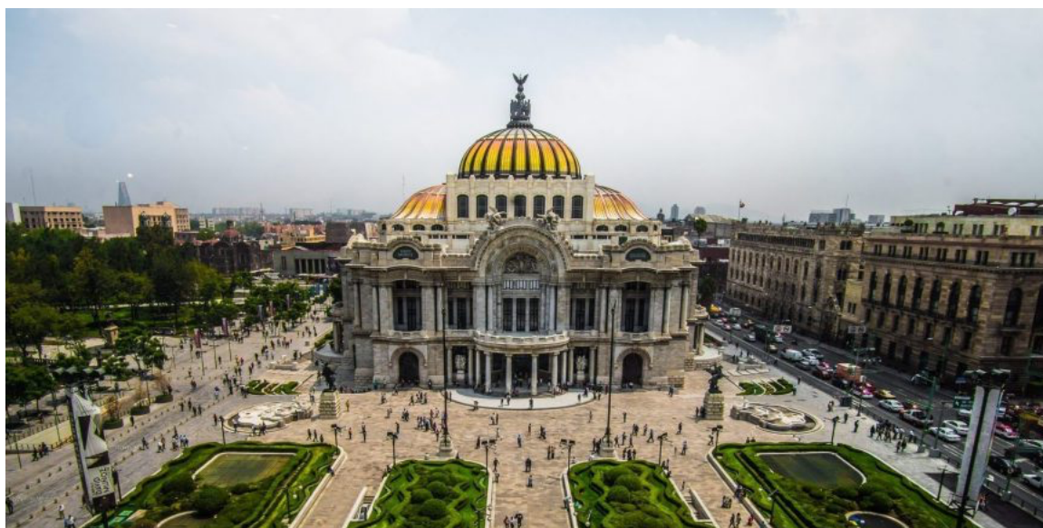
Figura 1.1 Assentamento uniforme de 4,5 metros do solo de fundação do palácio das belas artes, cidade do México, edificado em 1934. ( www.pinterest.pt ).
