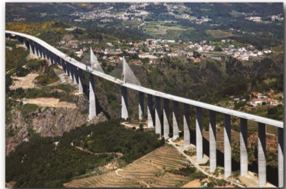
Viaduto do Corgo - FCC Construcción, RRC e Soares da Costa
