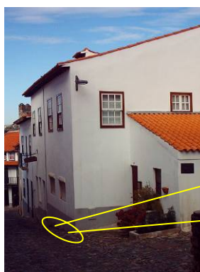
Figura 10 - Edifício após intervenção.
