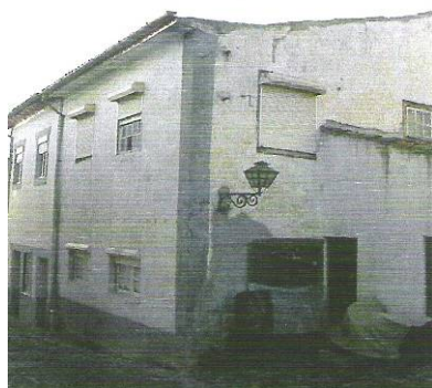
Figura 9 - Edifício antes da intervenção.
