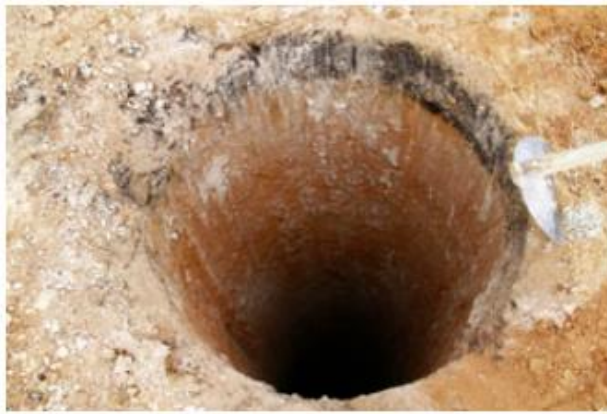
Figura 14 – Poços de prospecção em formato circular
