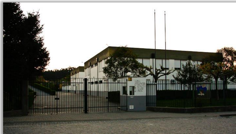
Figura 4 – Escola Básica e Secundária de Celorico de Basto 4
