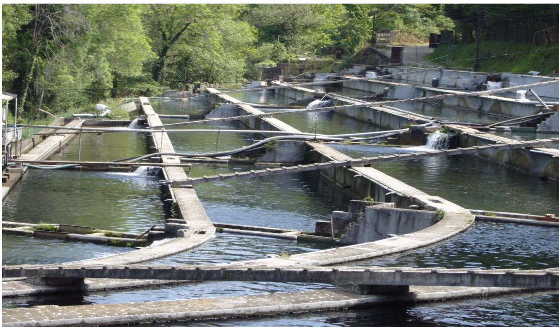
Figura 3.5: Pormenor do sistema de abastecimento de água nos tanques
