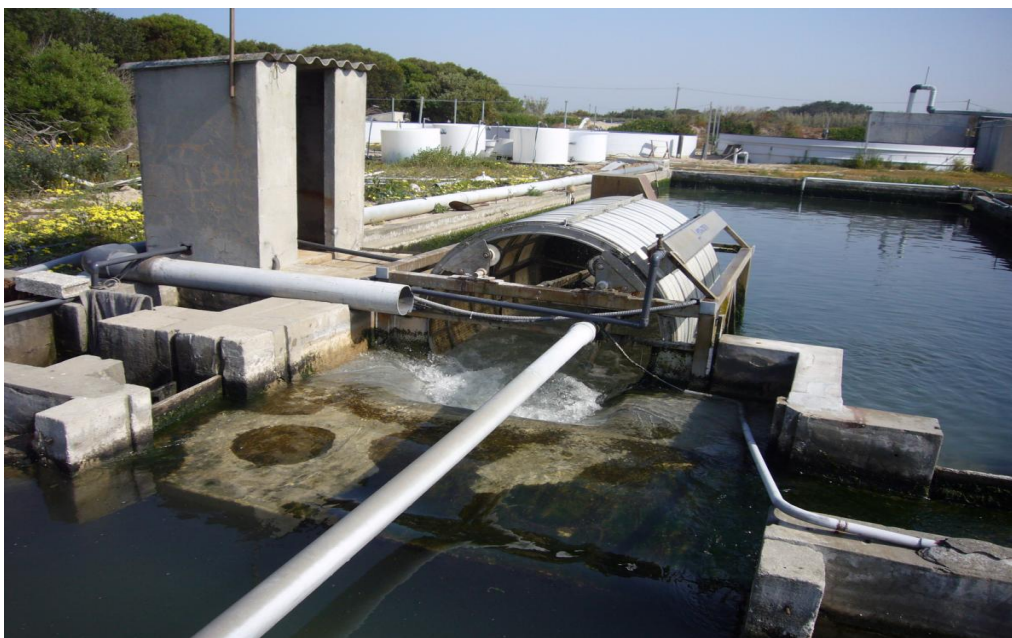
Figura 3.7: Aspeto do decantador de tratamento das águas provenientes da piscicultura (efluente), antes da emissão no mar
