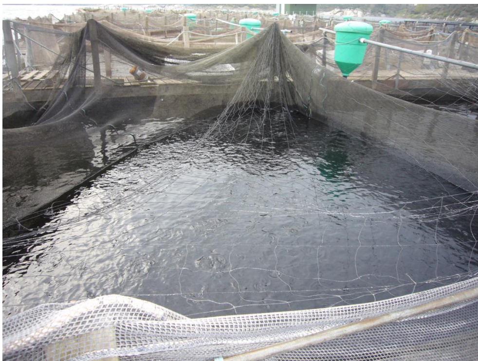
Figura 3. 4: Vista interior de uma gaiola, salientando-se a rede de cobertura e os passadiços.
