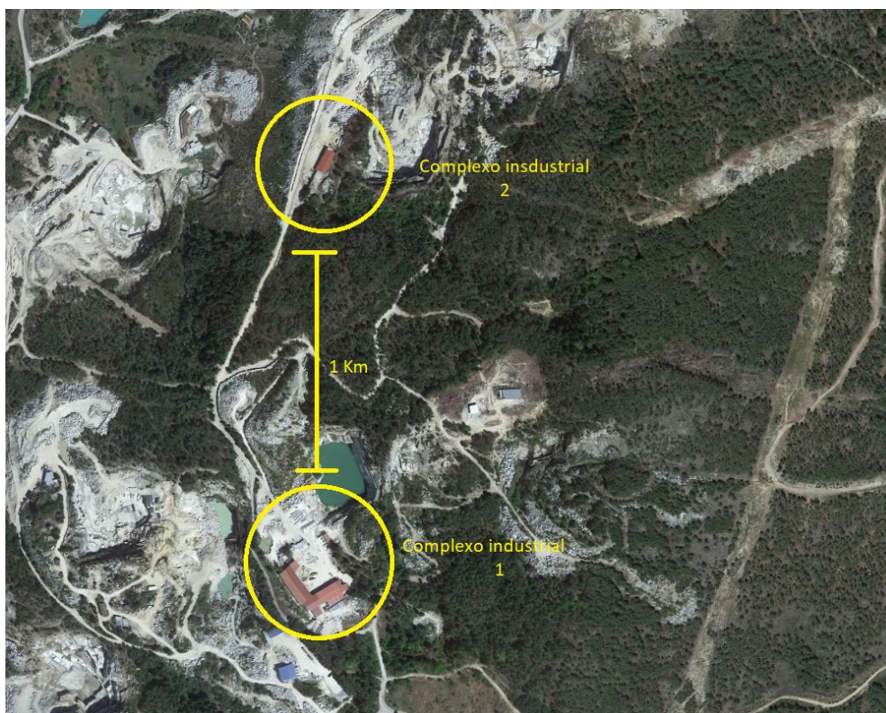
Figura 19 - Vista aérea da pedreira Oliveira Rodrigues [22].
