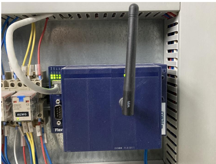
Figura 54 - Equipamento Ewon Flexy Wifi 20200 instalado no chão de fábrica do complexo industrial 2.
