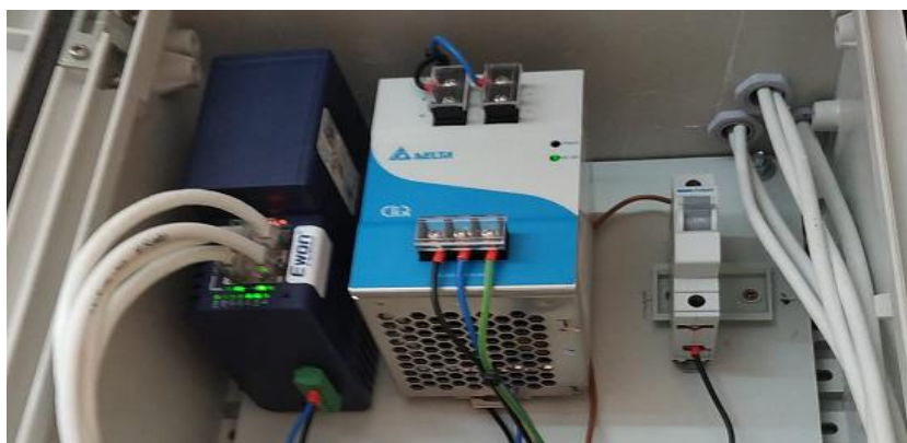
Figura 37 - Equipamento Ewon Flexy 205 instalado no chão de fábrica do complexo industrial 1.
