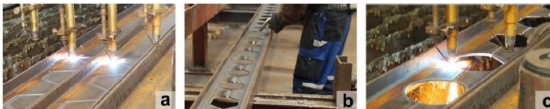
Figura 17 – Processo de fabrico das vigas casteladas e das vigas alveolares: (a) corte do montante da alma; (b) soldadura das vigas casteladas; (c) corte adicional das aberturas circulares para as geometrias CS2,[11].
