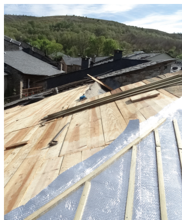
Figura 5 - Colocação de ripas ao longo do perímetro da cobertura e nas larós, rincões e cumeeiras
