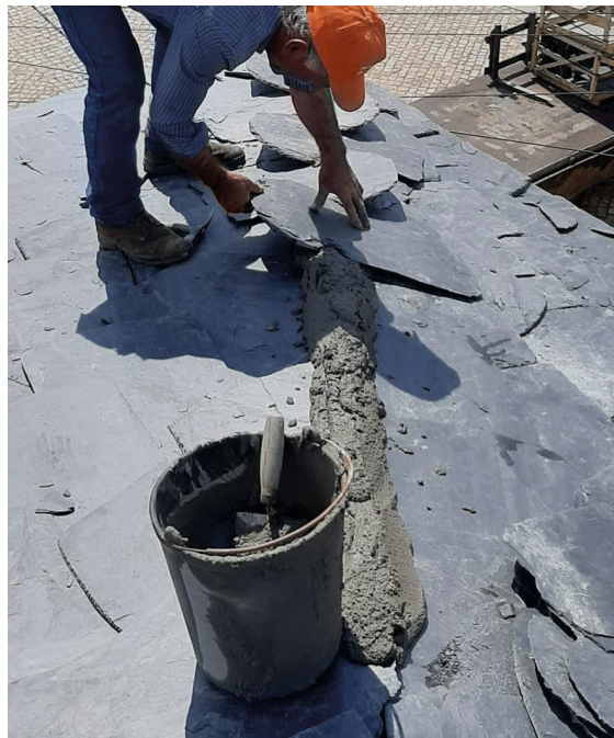
Figura 15 - Aplicação de camada de argamassa ao longo da cumeeira
