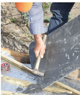
Figura 7 - Aplicação de leves pancadas com martelo ao longo da linha marcada
