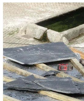
Figura 9 - Aspeto final da peça colocada sobre as ripas de madeira
