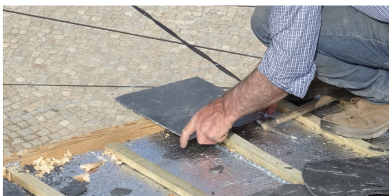
Figura 11 - Colocação da peça quadrangular pregada na ripa, que ficará debaixo da junta formada pelas duas peças colocadas em cima, funcionando como subtelha
