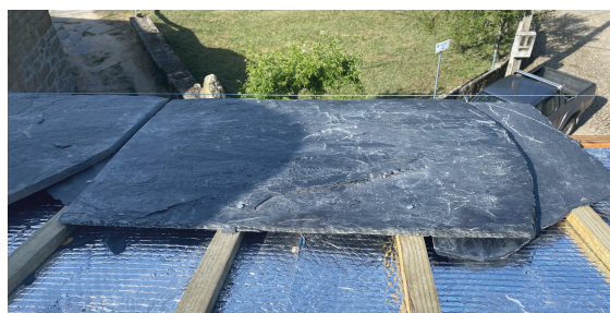
Figura 10 - Linha guia colocada e alinhamento das peças de lousa pelo fio de marcação
