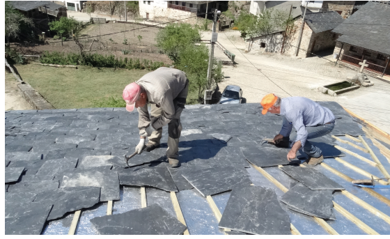
Figura 14 - Colocação das sucessivas peças de lousa
