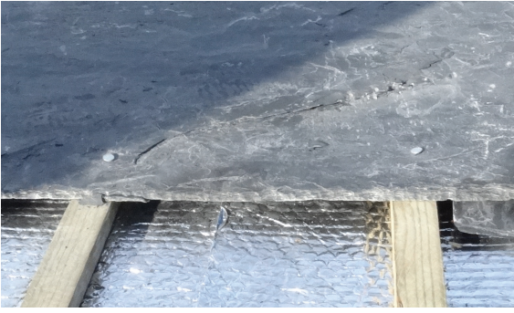
Figura 13 - Exemplo de peça de lousa fixa com dois pregos
