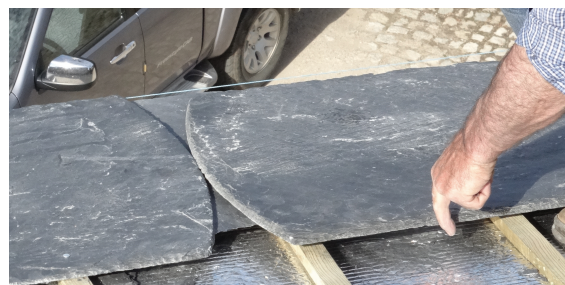
Figura 12 - Alinhamento de peças adjacentes ao beiral sobre uma peça pequena quadrangular previamente pregada ao ripado
