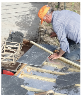
Figura 6 - Traçado da linha de corte com ponta de martelo
