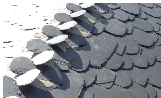
Figura 17 - Aspeto final da cumeeira
