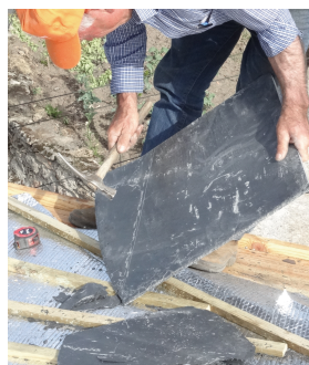
Figura 8 - Golpe final para quebra total do pedaço a retirar
