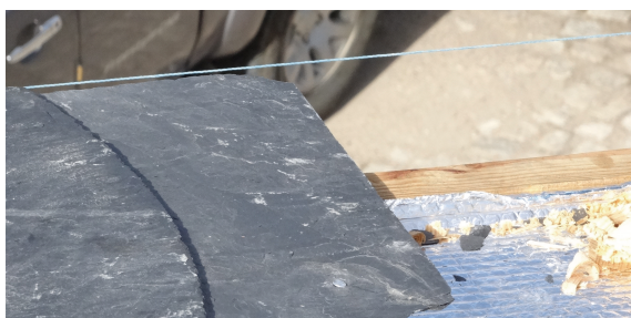
Figura 10 - Linha guia colocada e alinhamento das peças de lousa pelo fio de marcação
