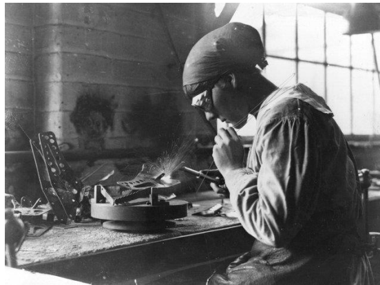
Figura 2 Fotografia de uma trabalhadora nos primórdios da soldadura [7]
