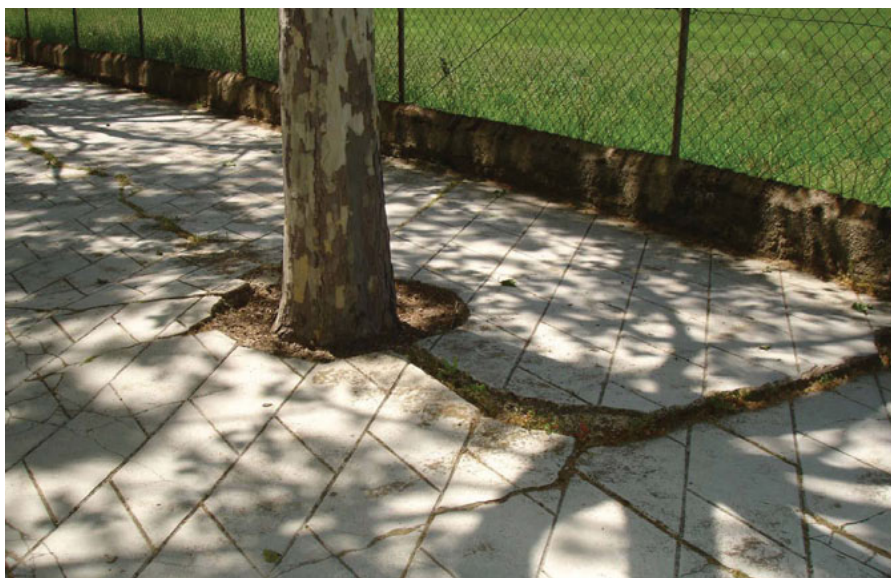
Caso de rebentação de pavimento de passeio provocado por Plátano. Alameda Santa Apolónia (árvore número 93039).
