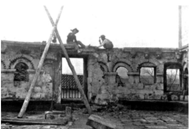
Figura 2.33 – Obras de restauro de 1932
