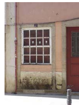
Figura 3.53 – Porta adaptada a janela para habitação, alterando o aspecto original da fachada do edifício
