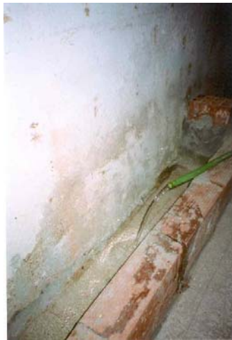
Figura 5.29 – Colocação de água em contacto com a parede
