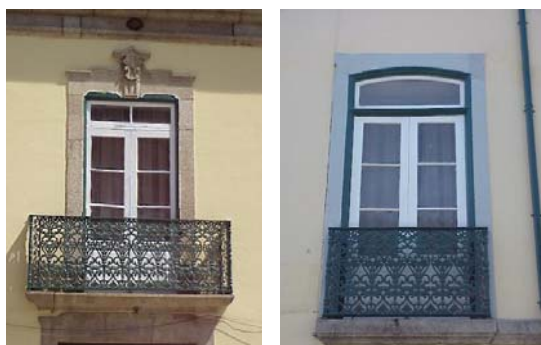
Figura 3.32 – Exemplo de dois gradeamentos bastante trabalhados, de sacada saliente e à face do plano da fachada
