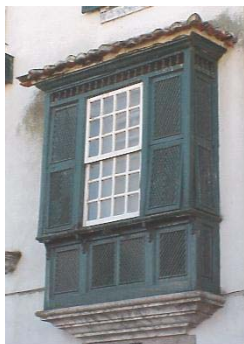
Figura 3.39 – Janela de guilhotina de quatro vidros saliente, provida lateralmente de reixas fixas e móveis
