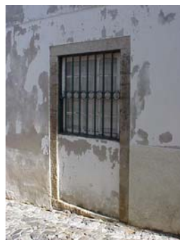
Figura 3.52 – Adaptação de um vão de porta a janela, através da criação de um pano de alvenaria, com janela de guilhotina e grade
