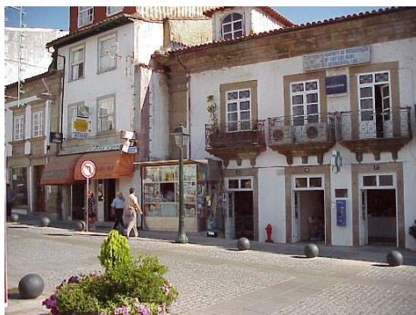
Figura 3.67 – Solar dos Calainhos, com um quiosque de linhas modernas encostado à fachada o que prejudica o edifício
