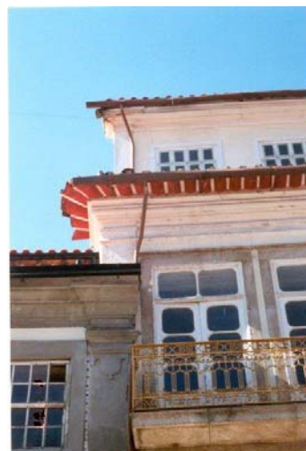
Figura 3.75 – Exemplo frequente de remates das cornijas sobrepostas em pilastras dando o efeito de edifícios distintos estarem sobrepostos
