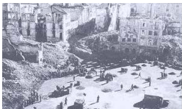
Figura 2.22 – Situação em que ficaram as casas da Praça do Castelo em Varsóvia
