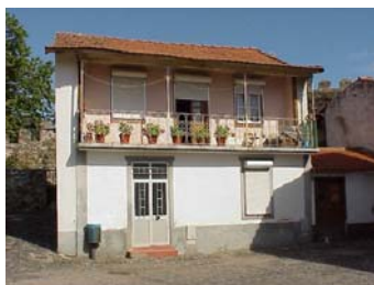
Figura 3.58 – Casa de habitação da Cidadela, com porta em alumínio e todas as janelas com estores em PVC
