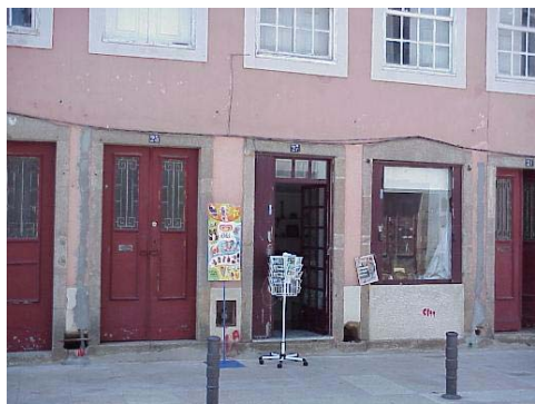
Figura 3.51 – Adaptação incorrecta da porta do edifício a montra de uma loja, com a criação de um pano de alvenaria e montra com caixilharia em alumínio
