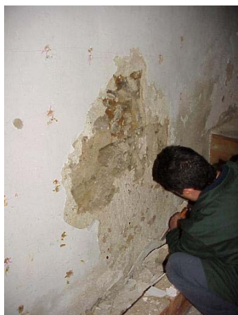
Figura 5.37 – Eliminação do reboco existente
