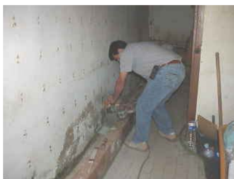
Figura 5.33 – Execução dos furos
