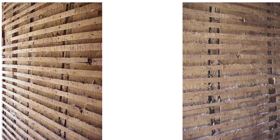
Figura 3.20 – Exemplo de parede interior em taipa de rodízio
