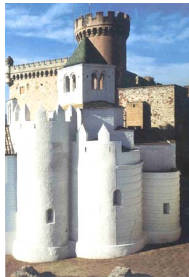
Figura 2.43 – Aspecto do castelo depois do restauro [40]
