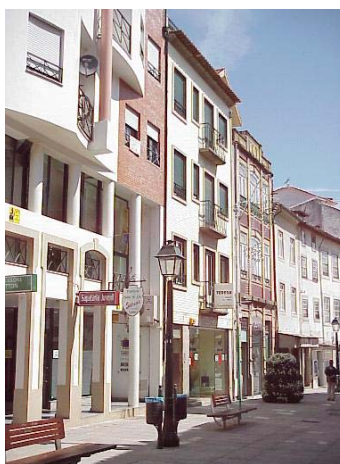
Figura 3.69 – Não deviam ser substituídos os edifícios originais dispostos em banda do início do século, por prédios modernos em betão armado
