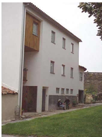
Figura 3.72 – Exemplo de reconstrução deficiente de um edifício na Cidadela, desde as proporções e dimensões do edifício, aos materiais empregues nos vãos e principalmente a má e desproporcionada imagem que transmite a esta zona histórica da cidade
