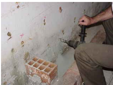
Figura 5.35 – Execução dos furos
