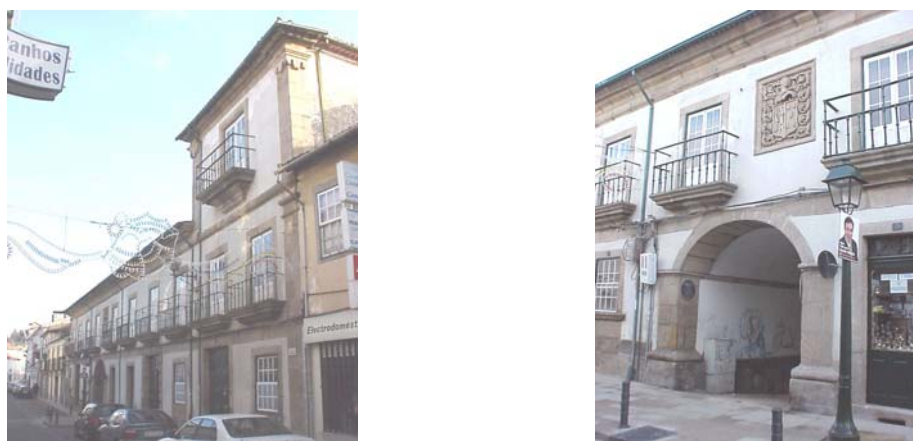
Figura 3.27 – Casa do Arco
