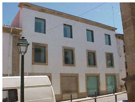
Figura 3.71 – Deficiente recuperação dos vãos de janelas e portas com substituição da caixilharia de madeira por metal de linhas muito modernas
