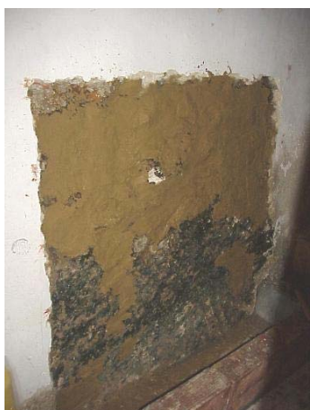
Figura 5.39 – Aplicação de reboco macro-poroso para regularização da parede
