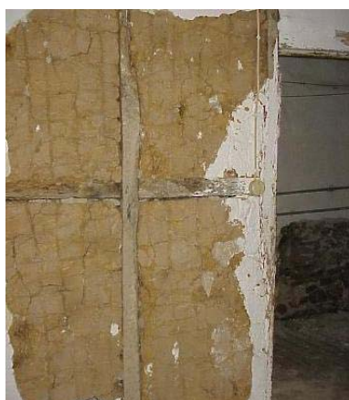
Figura 3.19 – Parede interior com construção tipo “Fachwerk”
