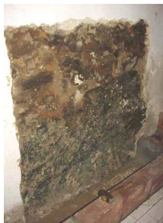
Figura 5.38 – “Janela” para colocação do reboco
