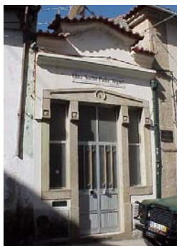
Figura 3.55 – Mau exemplo de colocação de porta e janelas laterais em alumínio
