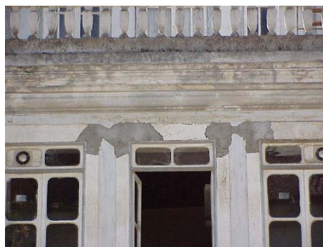
Figura 3.83 – Exemplo da colocação de argamassas de cimento num edifício do centro histórico
