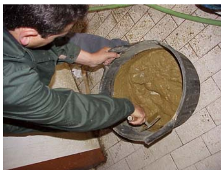
Figura 5.40 – Mistura da argamassa com movimentos lentos
