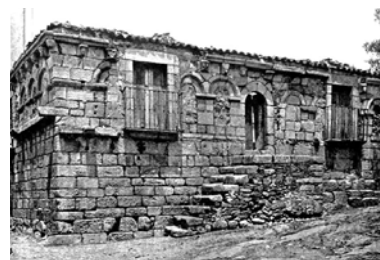
Figura 2.32 – Vista da escada lateral de acesso
