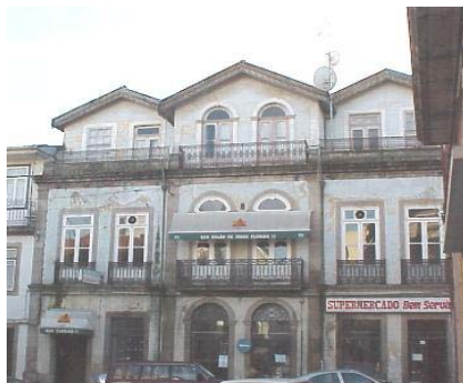
Figura 3.78 – Exemplo de um edifício em que por cima da falsa cornija fica um andar recuado, com três partes e com varandim. Os toldos e anúncios publicitários prejudica a leitura
