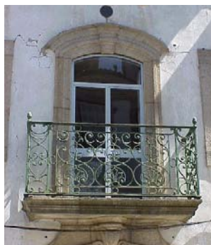
Figura 3.54 – Exemplo de uma janela em que a caixilharia de madeira foi substituída por uma de alumínio à cor natural
