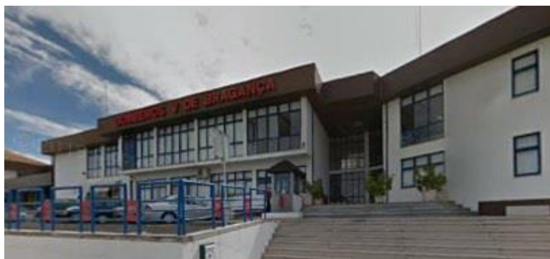
Figura 8. Fachada principal do edifício
