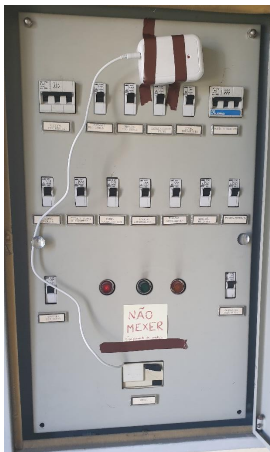
Figura 19. Instalação final do aparelho de medição
