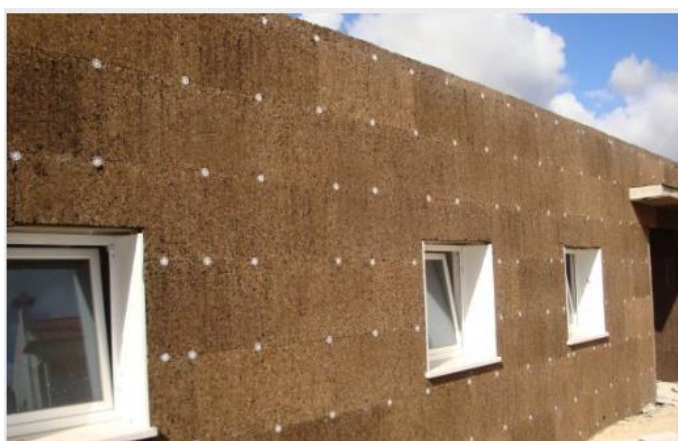
Figura 5 - Aglomerado de cortiça expandida aplicado em fachada externa[33].
