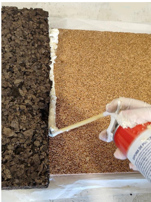
Figura 30 - Aplicação da espuma de poliuretano.
