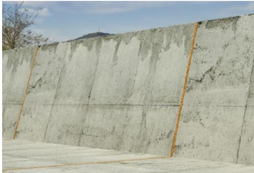
Figura 6 - Cortiça utilizada como junta de dilatação em barragem de concreto[34].
