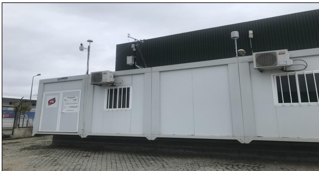
Figura 31 - Estação de monitoração de parâmetros de qualidade do ar e meteorológicos localizada na Zona Industrial Urbana de Mirandela (ZIM).
