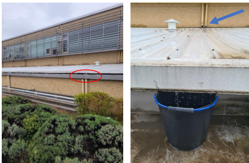
Figura 27 - Ponto principal da coleta de água. A vermelho está indicada a calha e a azul estão indicados os tubos de queda
