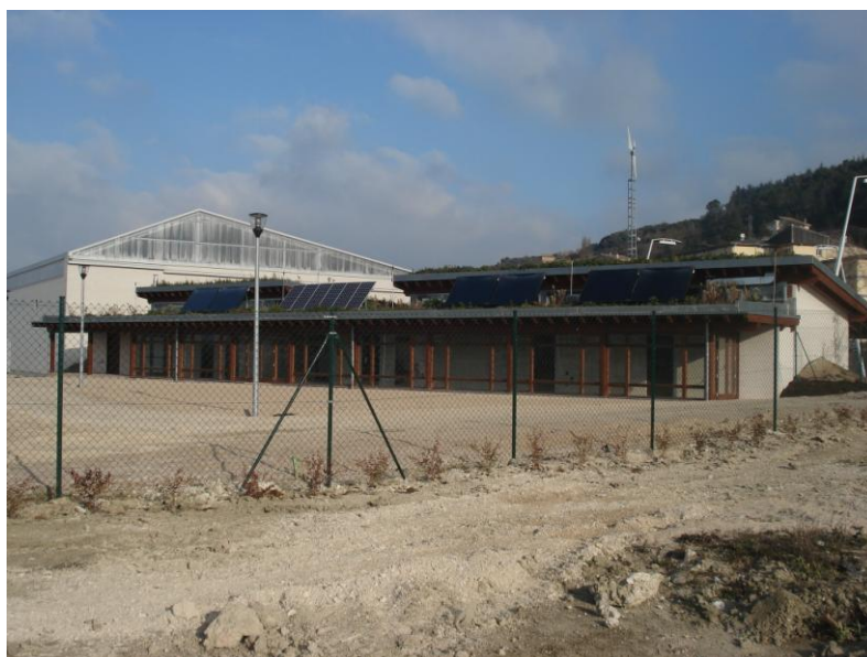
Fig. 7 – Vista Sul do edifício, onde podem ver-se os painéis solares e fotovoltaicos e parte do mini gerador eólico, no lado Norte.
