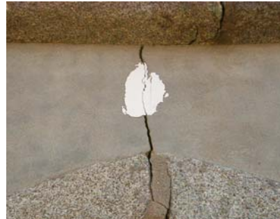
Figura 3.17: Testemunho em gesso ou pasta de cimento
