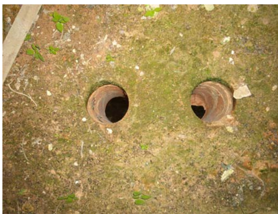
Figura 4.57: Local de extracção de 2 carote, no fecho da abóbada nervurada do 1º piso
