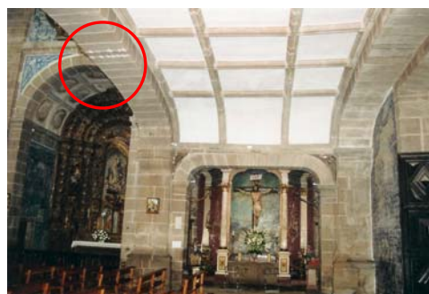
Figura 4.8: Resultado da intervenção num dos arcos laterais. Tentos no arco principal do coro alto
