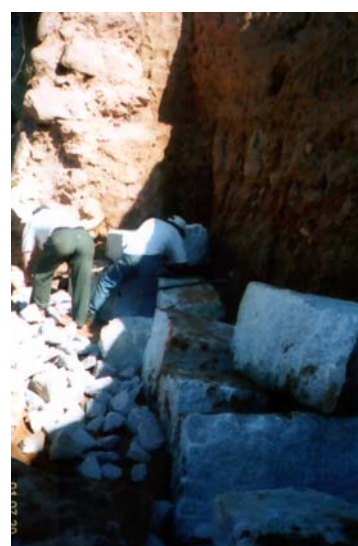
Figura 4.42 [4e]: Pormenor de execução em obra
