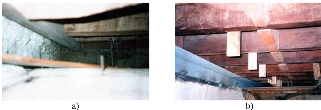
Figura 4.19 [4e]: a) Assentamento dos barrotes do coro antes da intervenção b) Apoio dos barrotes em chapa quinada fixa à fachada principal após intervenção
