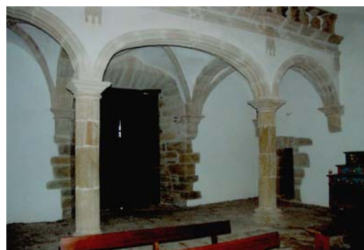
Figura 4.27: Pilares e arcos de sustentação do coro alto
