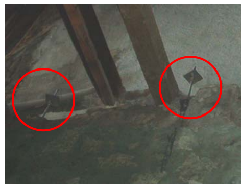
Figura 5.6: Pregagens para solidarização da nova estrutura reticulada. Chapas niveladoras e de ligação aos novos elementos a colocar
