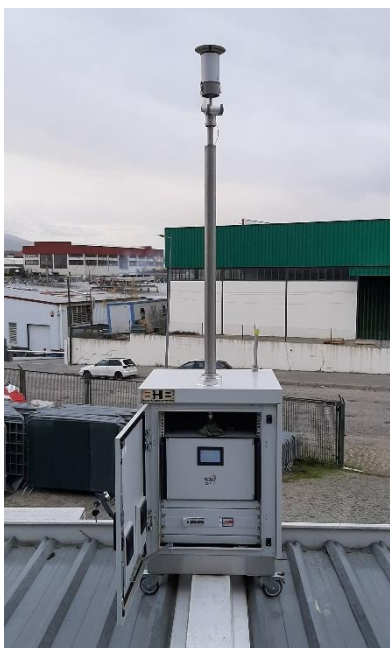
Figura 10 – Monitor contínuo de material particulado PM_{2,5}
