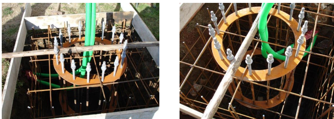
Figura 8: Escavação e alocação das armaduras. Fonte: Acervo do IPB.
