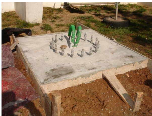
Figura 10: Concretagem e porcas de nivelamento.
