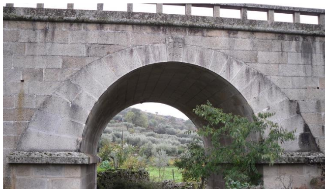
Figura 3.9 - Arco com espessura variável (ponte nº 57)
