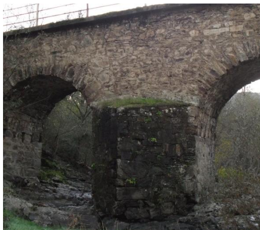
Figura 3.13 - Pilar da ponte da Arranca (ponte nº 71)
