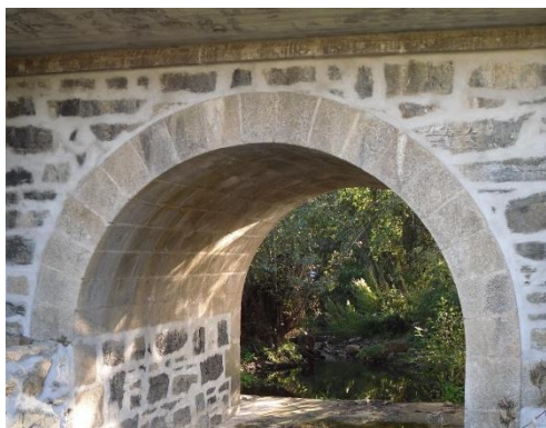
Figura 3.8 - Arco com espessura constante (ponte nº 5)
