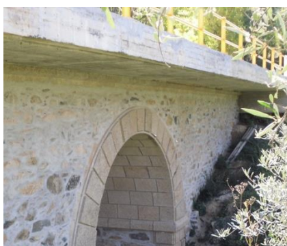
Figura 3.11 - Enchimento entre o tabuleiro alargado e a chave (ponte nº 9)
