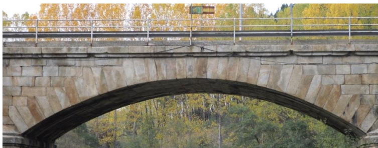
Figura 3.10 - Tabuleiro assente diretamente sobre o coroamento do arco (ponte nº 23)
