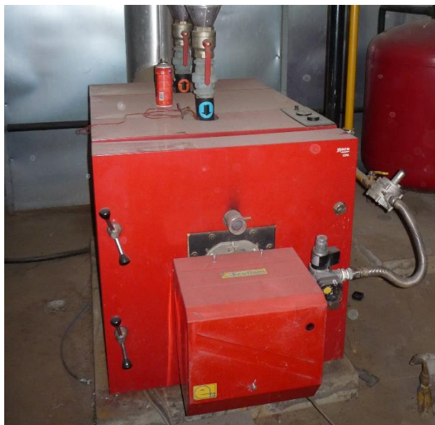
Figura 5.2.5.1-1 Caldeira e queimador da central térmica I
