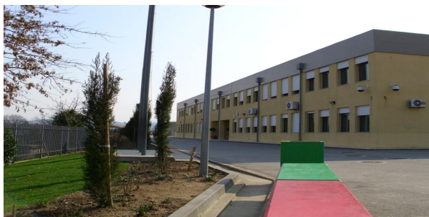
Figura 5 – Escola Integrada de Pedome, Sede de Agrupamento
