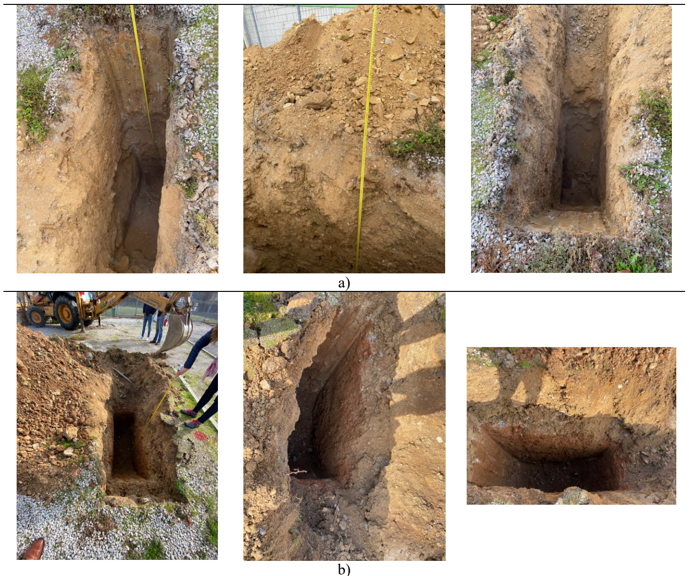
Figura 5 – Poços de prospeção: a) PI1; b) PI2
