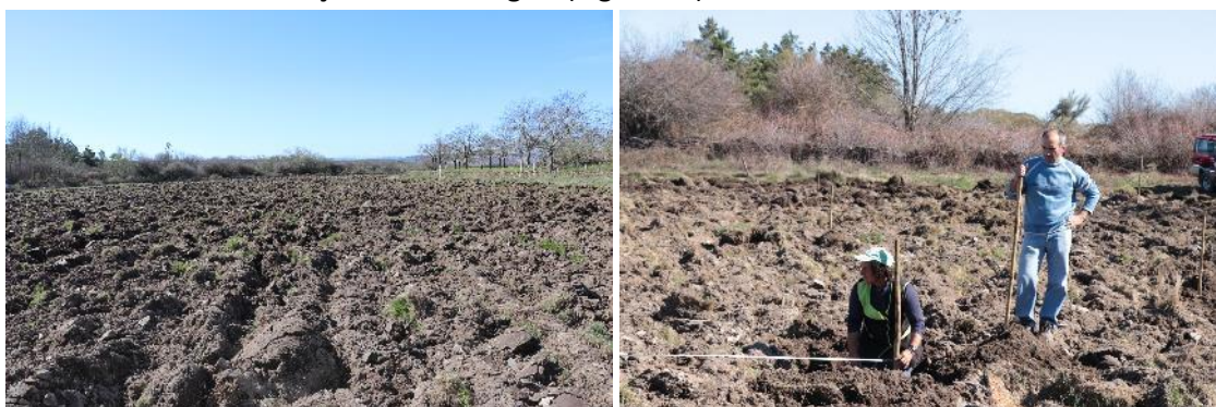
Figura 43- Aspeto do terreno após a realização da surriba (esquerda) e momento da realização da piquetagem (direita).
