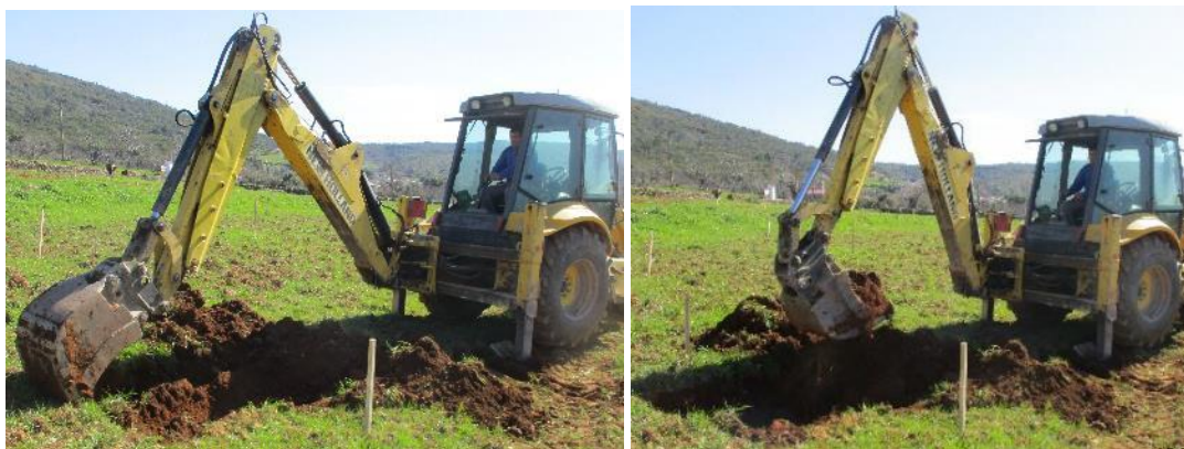
Figura 60– Abertura das covas com retroescavadora.
