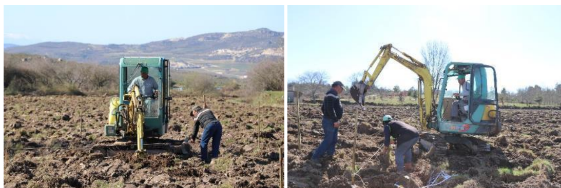
Figura 44- Abertura de covas para a realização da plantação.
