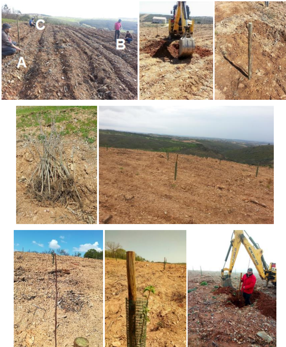
Figura 12- Instalação e retanCHA do SD de Parada
