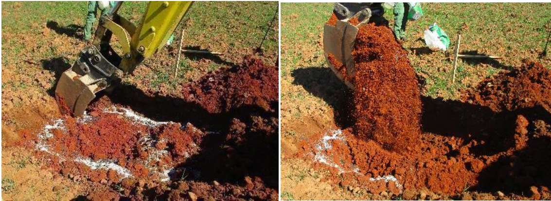
Figura 61– Ação da retroescavadora na mistura da terra com a fertilização de fundo.
