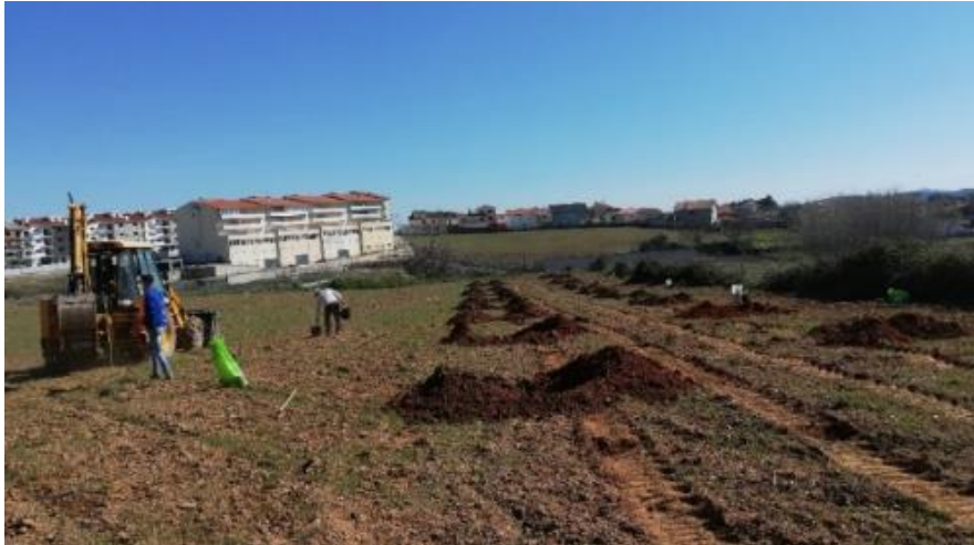
Figura 20– Plantação do SD CM-Va sob a coordenação da agriFUTURO (fevereiro de 2019).
