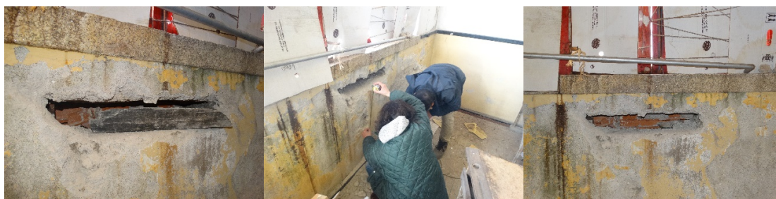
Figura 6 – Inspeção pelo interior da parede de fachada
