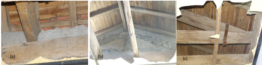
Figura 10 – (a) Aspeto da ligação asna à cornija em betão, (b) Cumeeira e madres assentes na parede de alvenaria de fachada, (c) Pormenor da samblagem Linha/Perna com braçadeira metálica
