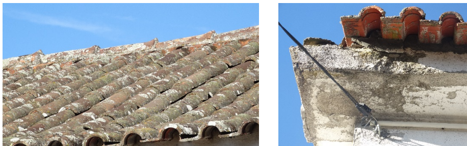
Figura 15 – (a) Aspetto exterior da telha de cobertura, (b) Aspetto das cornijas
