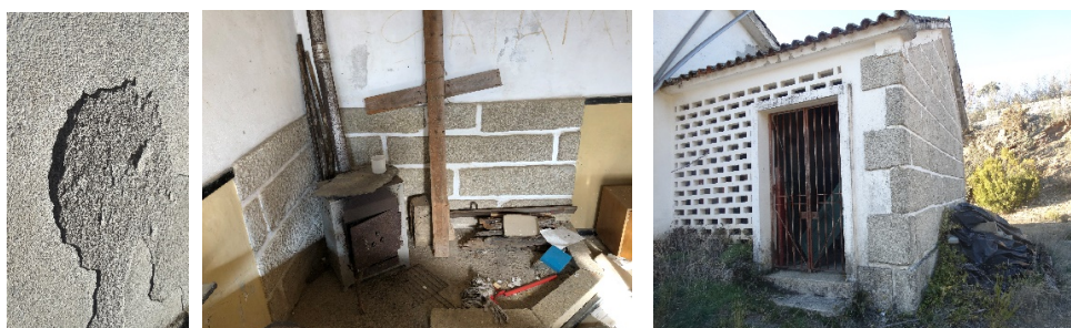
Figura 7 – (a) Reboco de base cimentícia, (b) Parede interior com aparelho à vista, (c) Parede exterior com aparelho à vista
