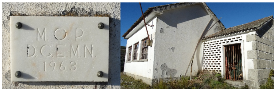
Figura 4 – (a) Placa alusiva à data de construção, (b) Aspetto da fachada principal do edifício
