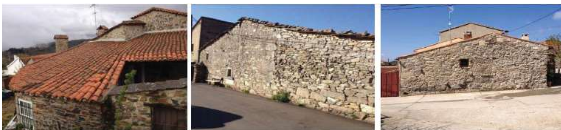
Figura 11 – Exemplos de cobertura captadora localizadas na região transfronteiriça entre o norte de Portugal e a Espanha [37]
