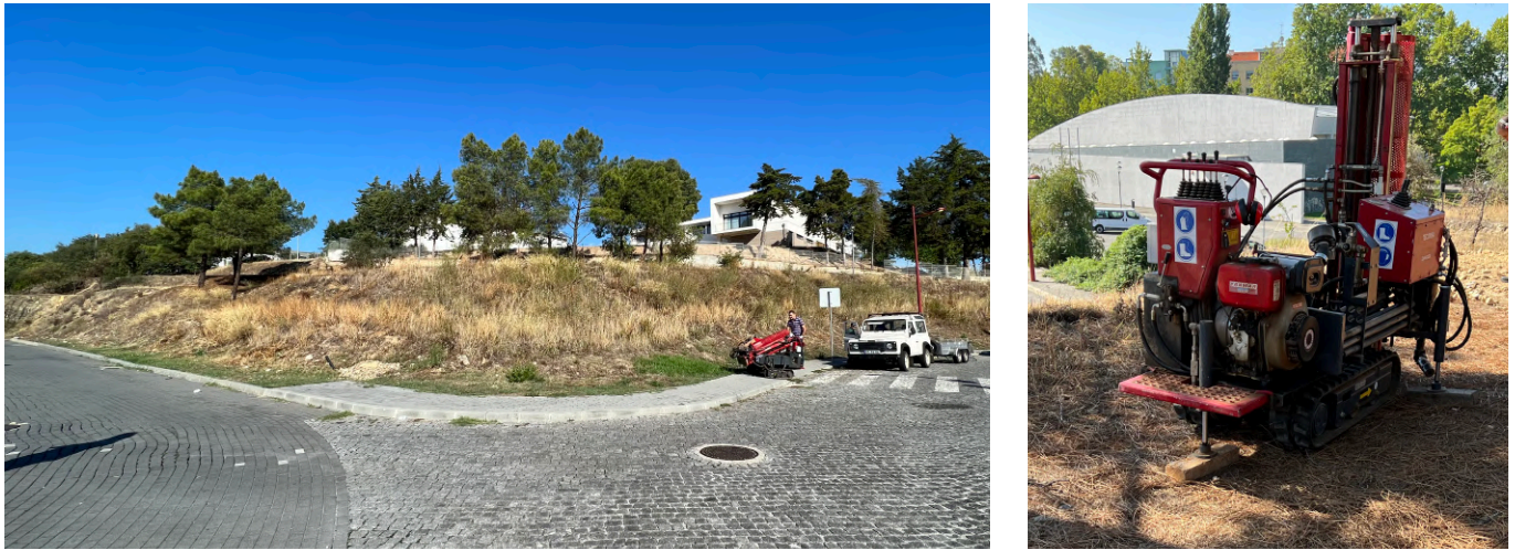
Figura 2 – Local de realização dos ensaios e equipamento de perfuração.
