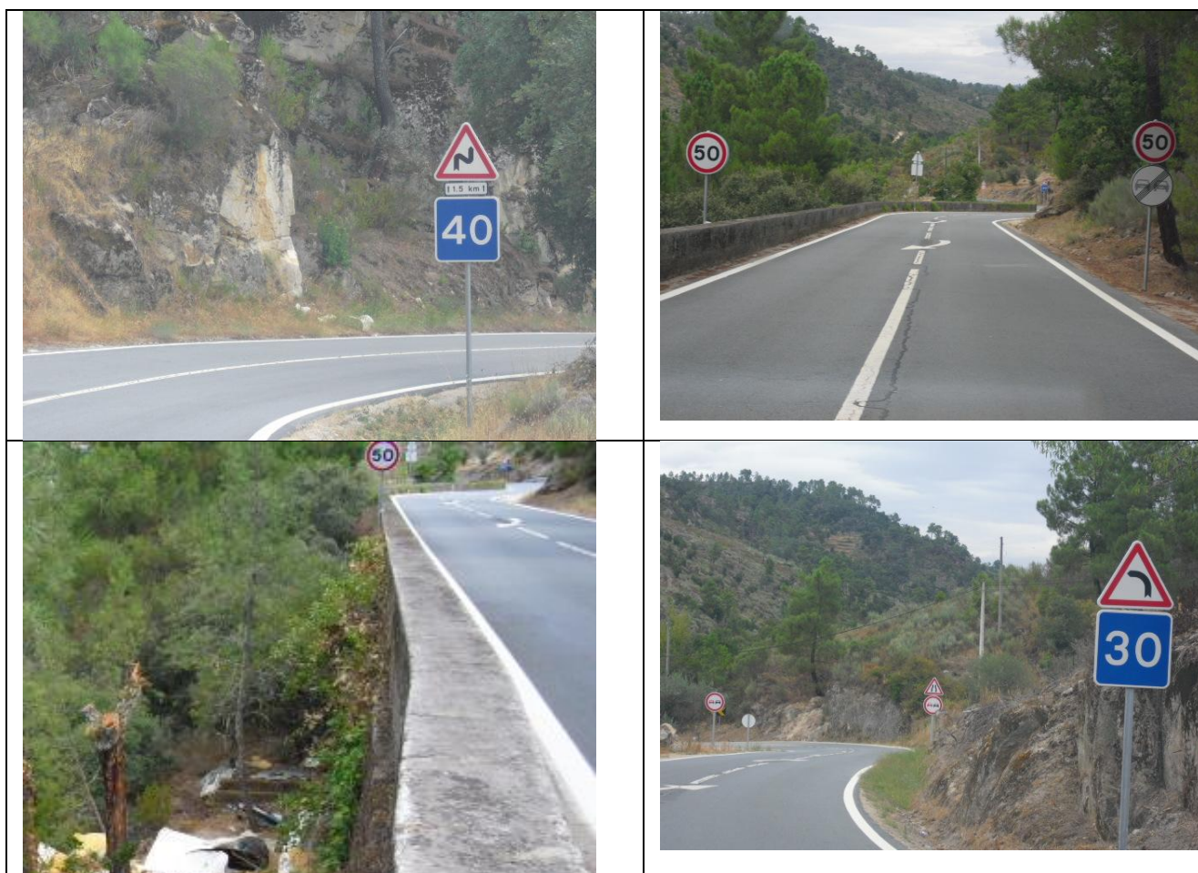
EN 206 - Km 178+600 ao km 178+200 - sentido decrescente – fotos de Ago. e Set. -2010
