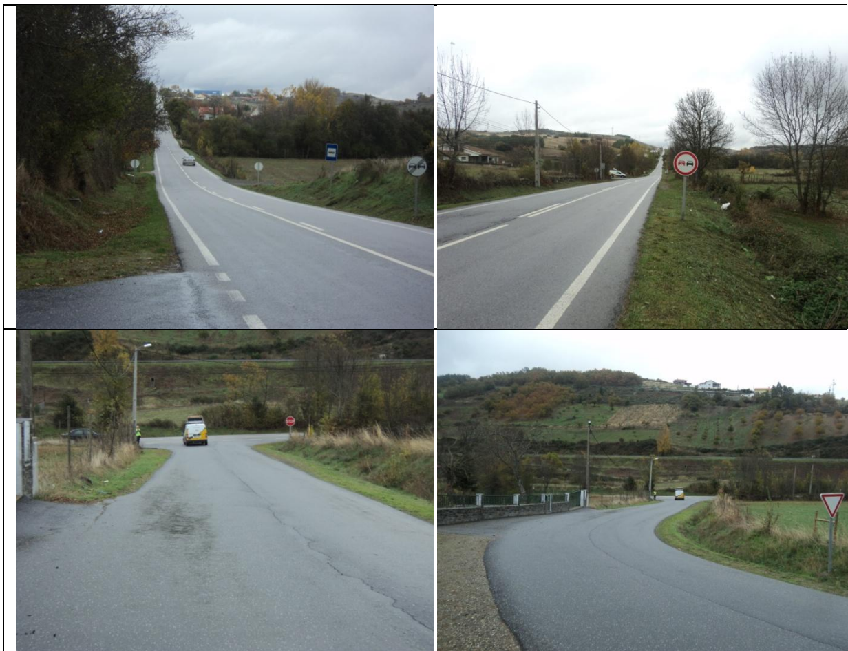
Entroncamento da EM 526
