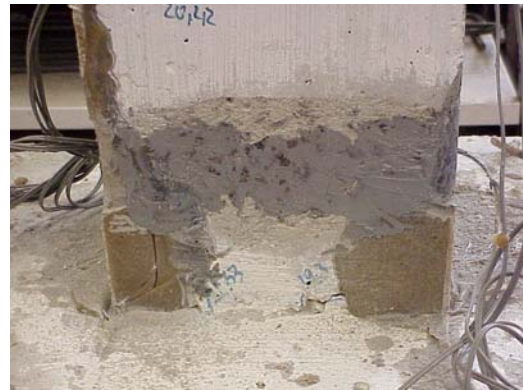
Figura 3.39 – Aplicação do primário.
