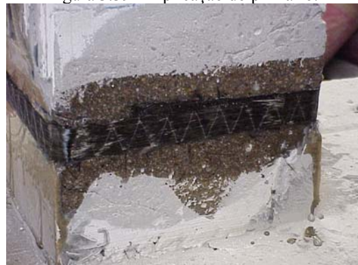
Figura 3.41 – Colagem da faixa de tecido de fibras de carbono.
