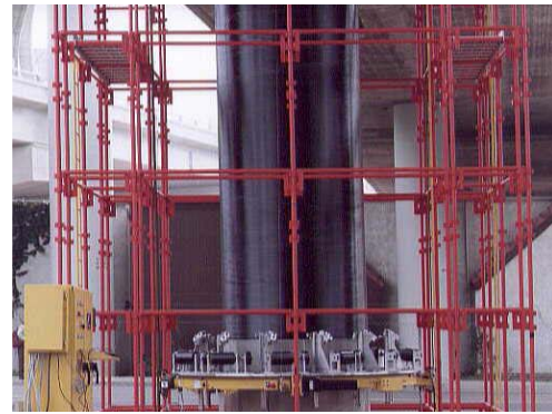
Figura 2.20 – Aplicação de cordões de CRFP, através de uma máquina de encamisamento.
