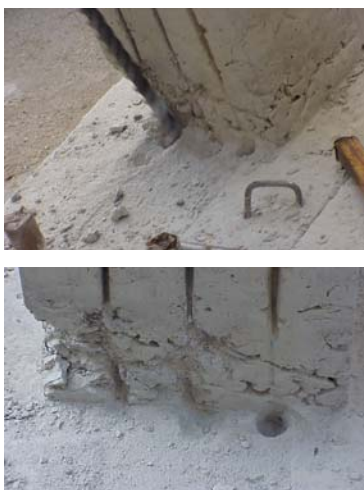
Figura 2.14 – Abertura de orifícios para fixação dos laminados à sapata.
