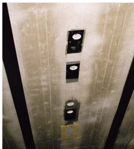
Figura 2.7 – Aspecto final da aplicação de laminados no reforço de uma estrutura de betão armado.
