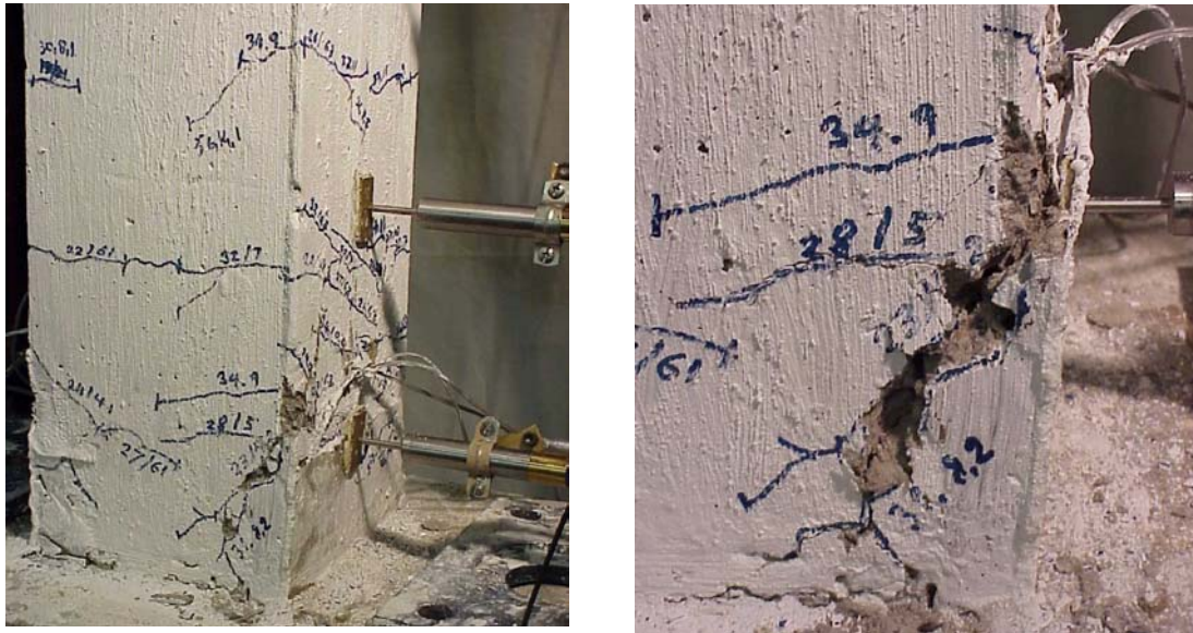
(a) (b) Figura 5.45 – Aspecto exterior do P10aCR: (a) vista geral; (b) pormenor da zona da secção de rotura.
