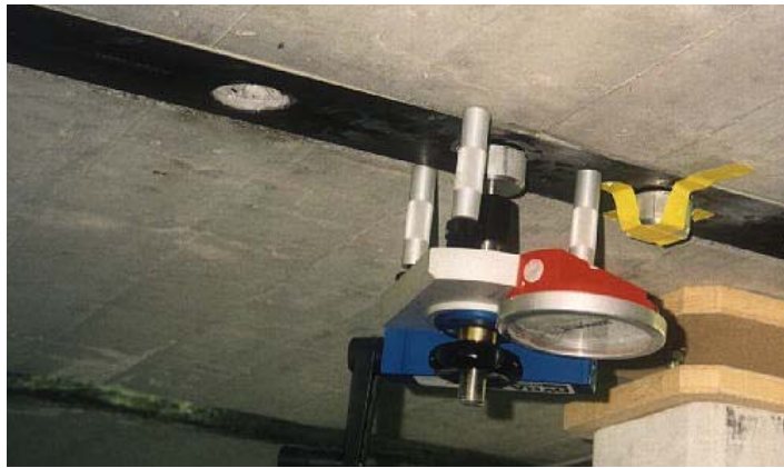
Figura 2.5 – Avaliação da resistência à tracção do betão por arrancamento.
