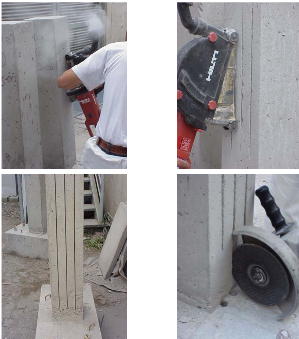
Figura 3.19 – Abertura das ranhuras nos pilares.
