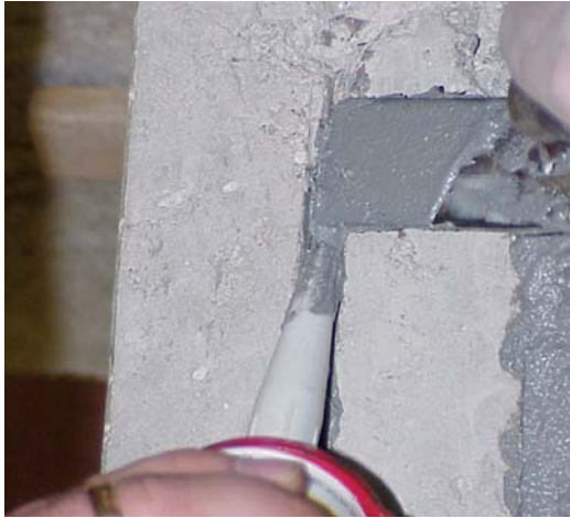
Figura 3.30 – Aplicação da resina epóxida nas ranhuras.
