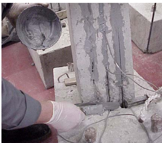
Figura 2.16 – Fixação dos laminados a um elemento de pilar.
