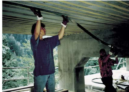
4º - Junção do laminado com a superfície de betão a reforçar, seguindo-se a compressão do conjunto para uniformizar a espessura de colagem, com a exclusão das partes de adesivo em excesso;
