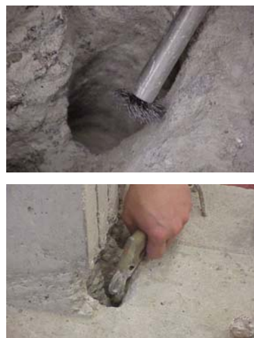
Figura 2.15 – Limpeza dos orifícios para fixação dos laminados à sapata.
