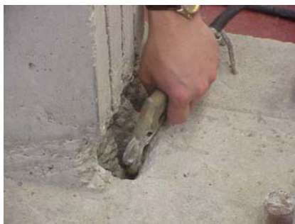
Figura 3.21 – Limpeza dos orifícios com jactos de ar comprimido.
