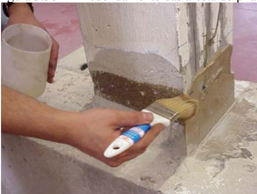
Figura 3.40 – Aplicação da uma demão de mistura epóxida.
