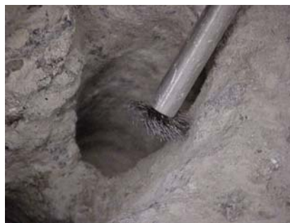
Figura 3.22 – Limpeza dos orifícios com pincel de aço.
