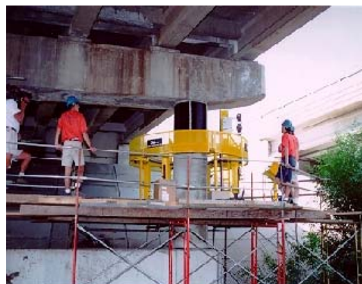
Figura 2.21 – Processo de encamisamento de um pilar de uma ponte utilizando uma máquina de ensamisamento.
