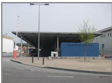
Figura 26 - Registo fotográfico da estação rodoviária de
