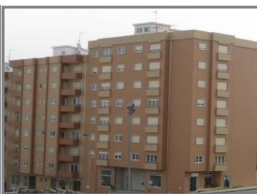
Figura 25 - Registo fotográfico de um prédio
