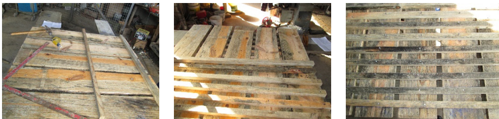
Figura 3: Sistema estrutural da parede de tabique
