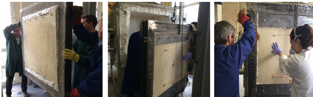
Figura 7: Montagem da parede no forno
