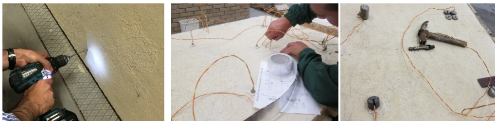
Figura 6: Instrumentação da parede de tabique com termopares
