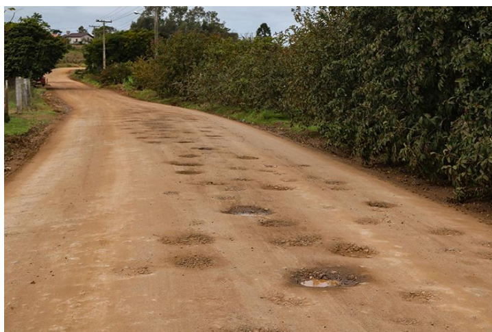
Figura 15 - Buracos em estradas não pavimentadas Fonte: Rosa (2022).
