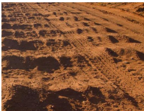
Figura 12 – Ondulações em estradas não pavimentadas Fonte: Wolf (2021)
