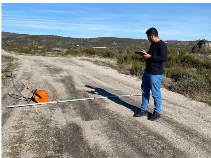
Figura 28 – Equipamentos utilizados na avaliação da via
