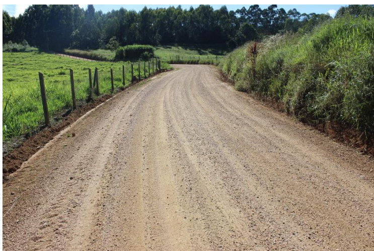
Figura 14 – Agregado solto em estradas não pavimentadas Fonte: Ludgero (2021).
